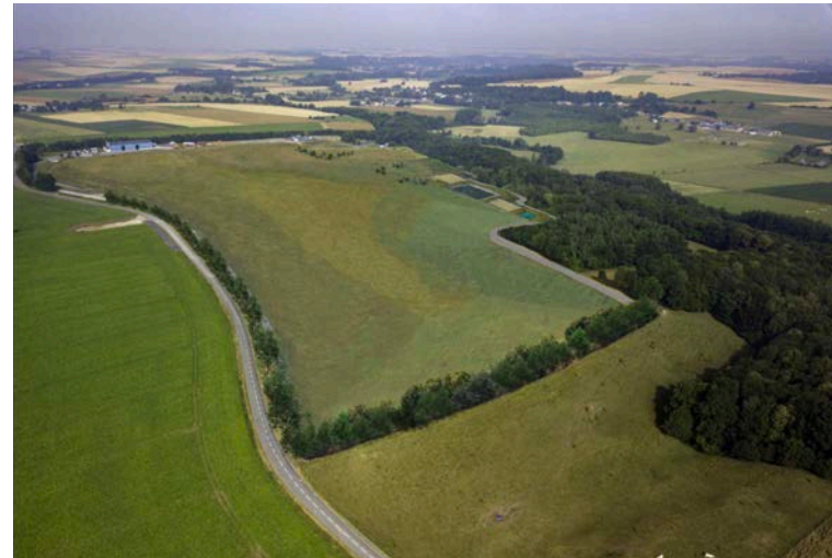
Vue aérienne casier D réaménagé
